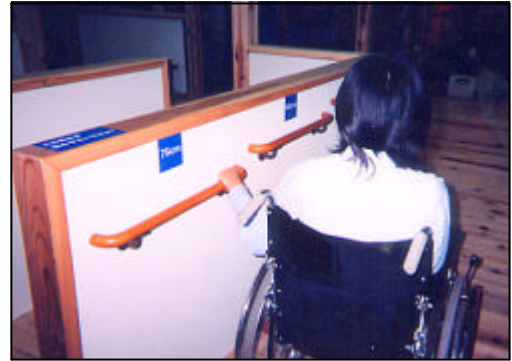
写真5 手すりの高さ 左から75cm, 80cm, 85cm 身長や用途に合わせている色々な高さに設置する。 75cmを標準とするが,大転子骨の高さが最適。
