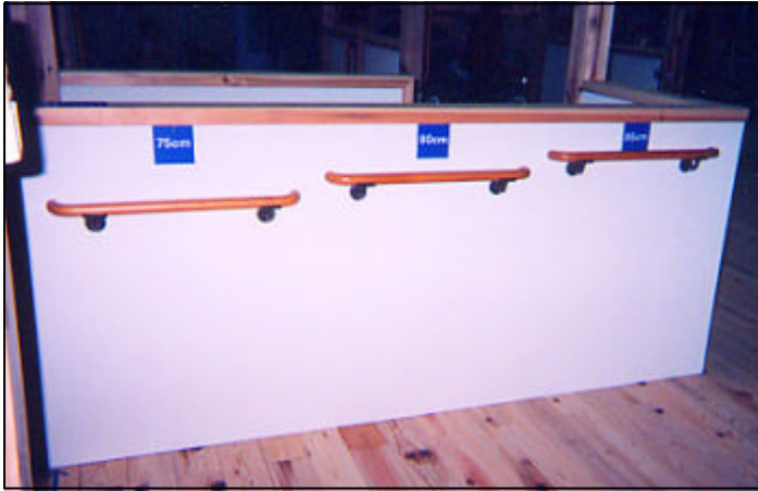
写真5 手すりの高さ 左から75cm, 80cm, 85cm 身長や用途に合わせている色々な高さに設置する。 75cmを標準とするが,大転子骨の高さが最適。
