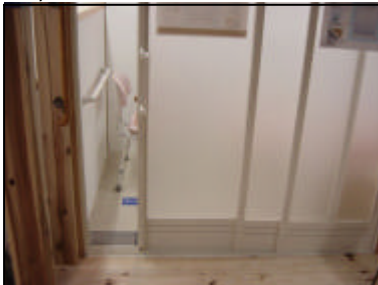
写真9 浴室入り口 3枚扉で開口部を大きくし,段差を無くして車椅子でも出入りしやすくなっている。
