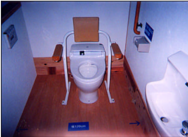
写真7 車椅子対応便所 幅120cm 手すりと背もたれがついて,車椅子でも使える。 介護者も介護しやすい広さである。
